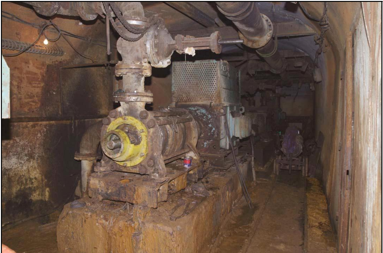
Wasserhaltung mit Kreiselpumpe
