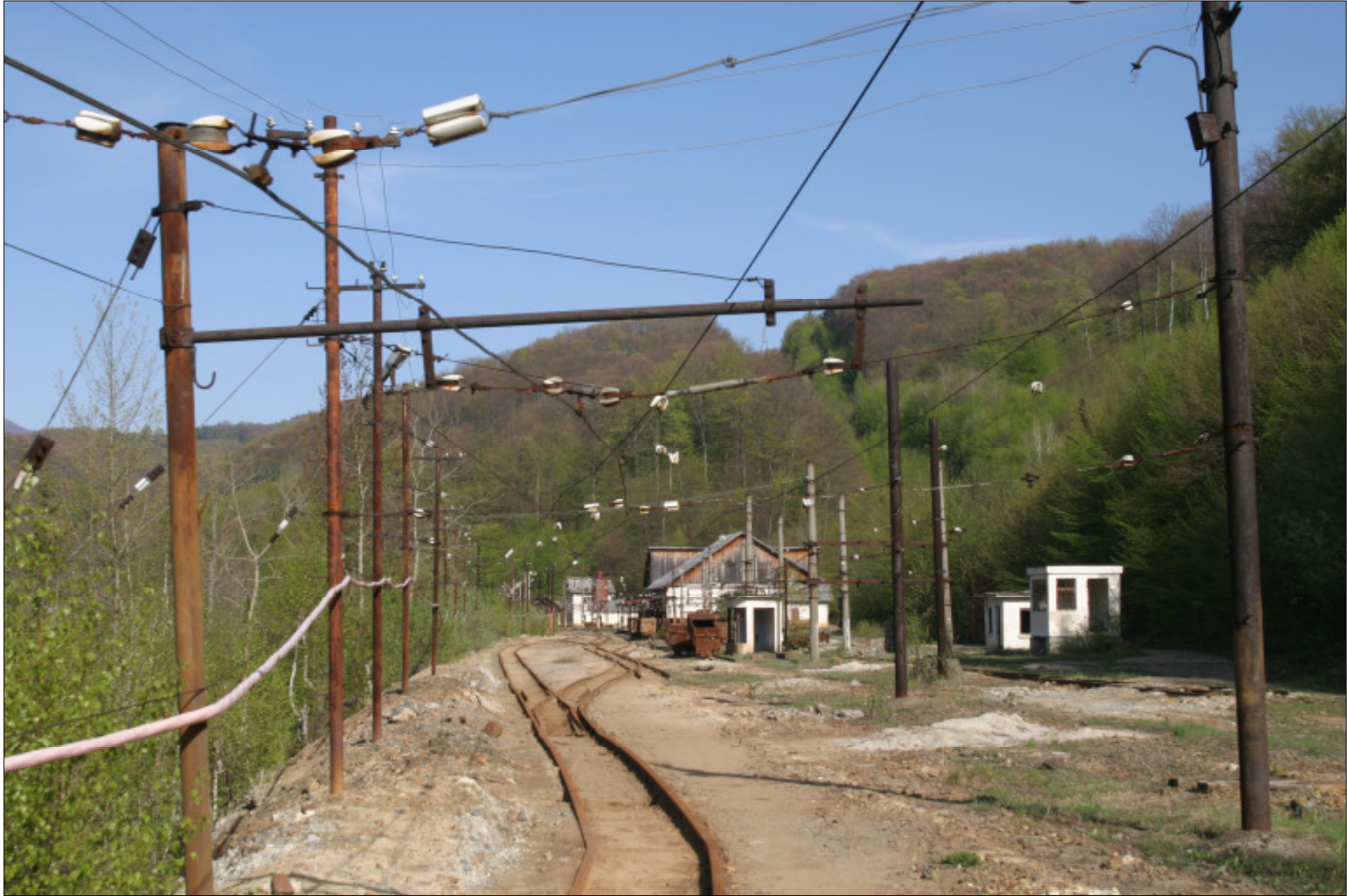
Grubenbahnhof vor der Galeria Tunnel
