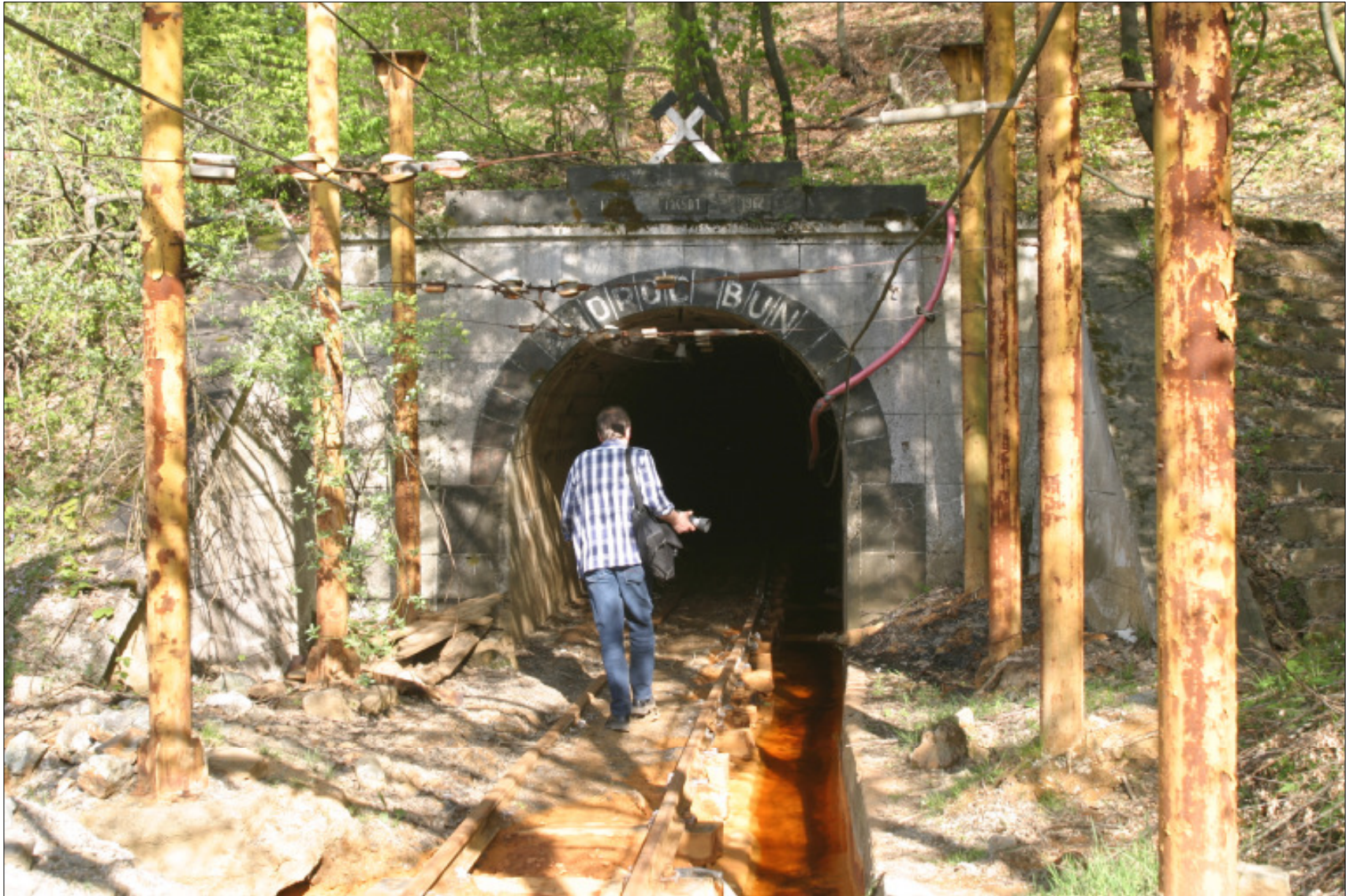
Mundloch des 11 km langen Stollens
