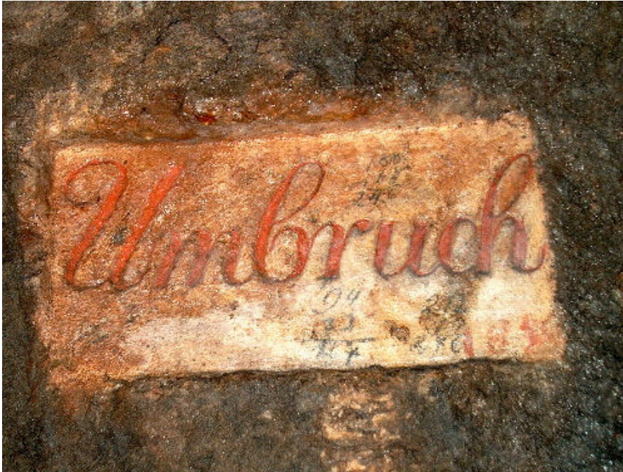
· Bild 2-22: Tafel an einem Umbruch, mit Bleistiftnotizen des Markscheiders. Thelersberger Stollen, Brand-Erbisdorf, Sachsen.
