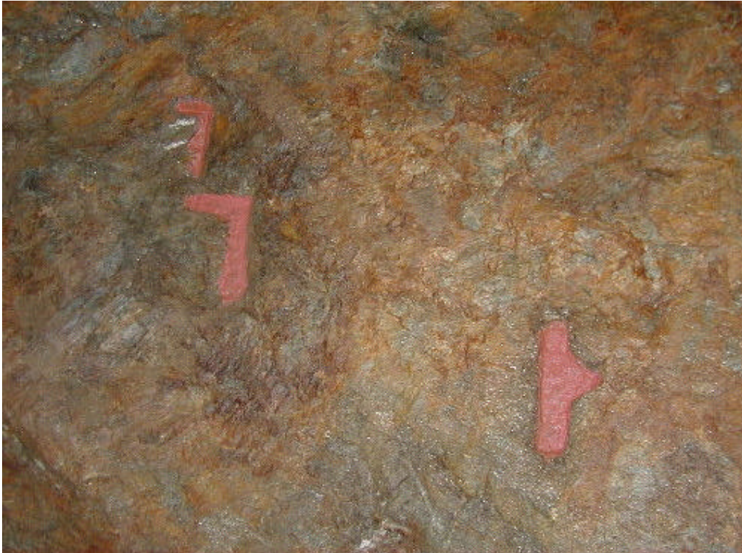
· Bild 1-48: Freiburger Gedingezeichen, für das Nachreißen der Firste, darunter ein Quartalswinkel für das Nachreißen der Firste und ein einfaches Gedingezeichen, um 1800. Das einfache Gedingezeichen ist verkehrt eingeschlagen, denn der Stollen endet rechts blind. Trau auf Gott Erbstolln, Lichtenberg bei Freiberg, Sachsen.
