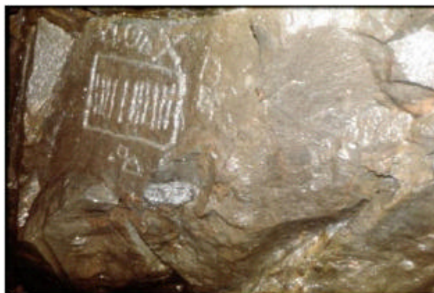
· Bild 6-07: Markscheidetafel mit römischen Zahlzeichen, Dreieck und Quadrat ungeklärter Bedeutung. Schultestollen, Harz.
