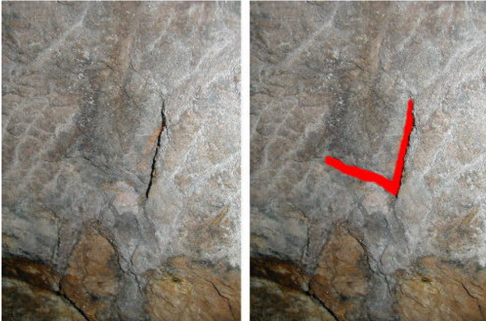
· Bild 1-26: Quartalswinkel aus dem Zentralrevier von Kamsdorf, Thüringen. Das Zeichen ist verkehrt eingeschlagen, die an den Prunen erkennbare Vortriebsrichtung stimmt nicht mit der durch das Zeichen angegebenen Richtung überein.
