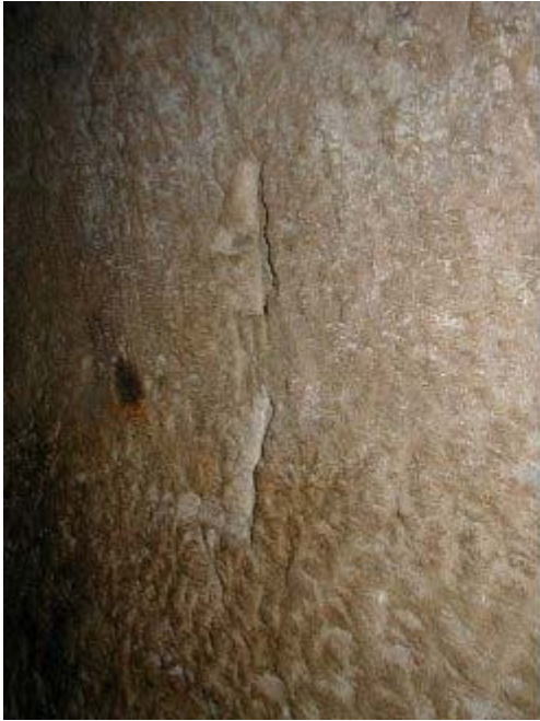
· Bild 1-12: Einfaches Freiberges Gedingezeichen mit einem Quartalswinkel, aus der Grube Reiche Zeche, Freiberg, Sachsen.
