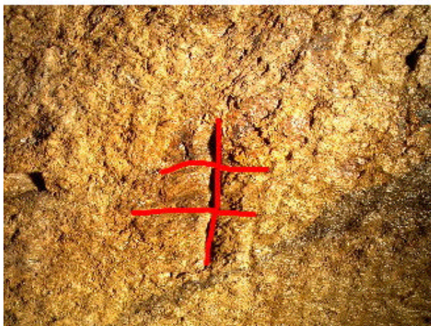
• Bild 2-15: Grubenfeldgrenze als Doppelkreuz. Am gegenüber liegenden Stoß befindet sich ebenfalls in Doppelkreuz (siehe Bild 2-16). Grube im Kiesholz, Marienberg, Sachsen. Zweite Hälfte 16. Jahrhundert. Übersichts- und Detailfoto.
