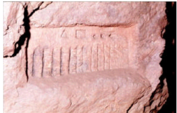
· Bild 6-06: Markscheidetafel mit römischen Zahlzeichen, Dreieck und Quadrat ungeklärter Bedeutung. Knollengrube, Harz.
