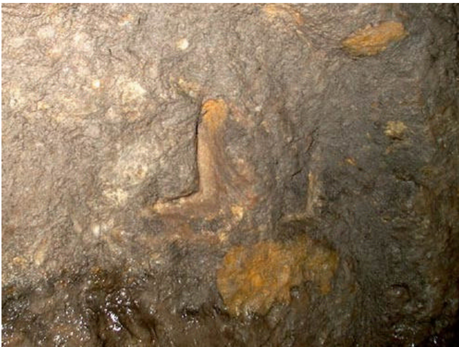
· Bild 1-27: Zwei Quartalswinkel. Flügelort des Treue Gewerken Verbindlichkeit Stollens in Kamsdorf, Thüringen.
