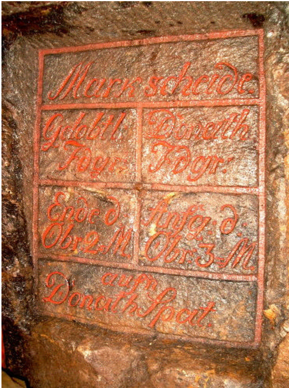
• Bild 2-20: Grubenfeldgrenze der Gelobt Land Fundgrube zur Donath Fundgrube auf dem Donath Spat. Thelersberger Stollen, Brand-Erbisdorf, Sachsen.
