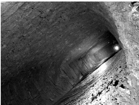
Abb. 11: Blick in das Gesenk 5 am Martinschacht. Der Grundwasserspiegel liegt reichlich 10 Meter unter der tiefsten Wasserlösung, dem TGV- Stollen.
