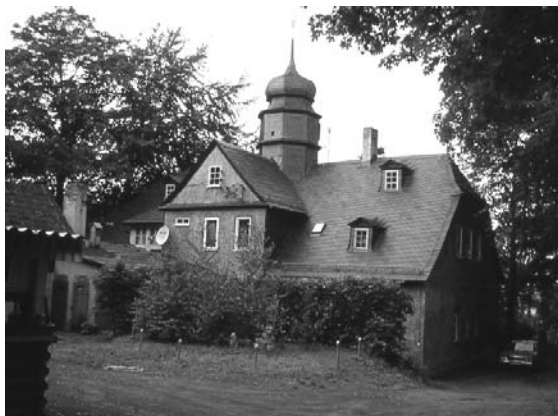
Abb. 3: Das ehem. Revierhaus in Kamsdorf
