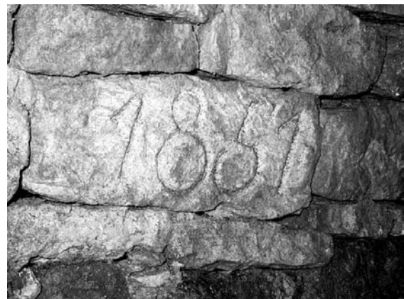
Abb. 4: Jahreszahl für das Setzen eines Gewölbes im Neuhoffungstollen
