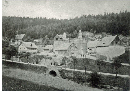
Bild 1: Kalkwerk Heidelberg um 1890
