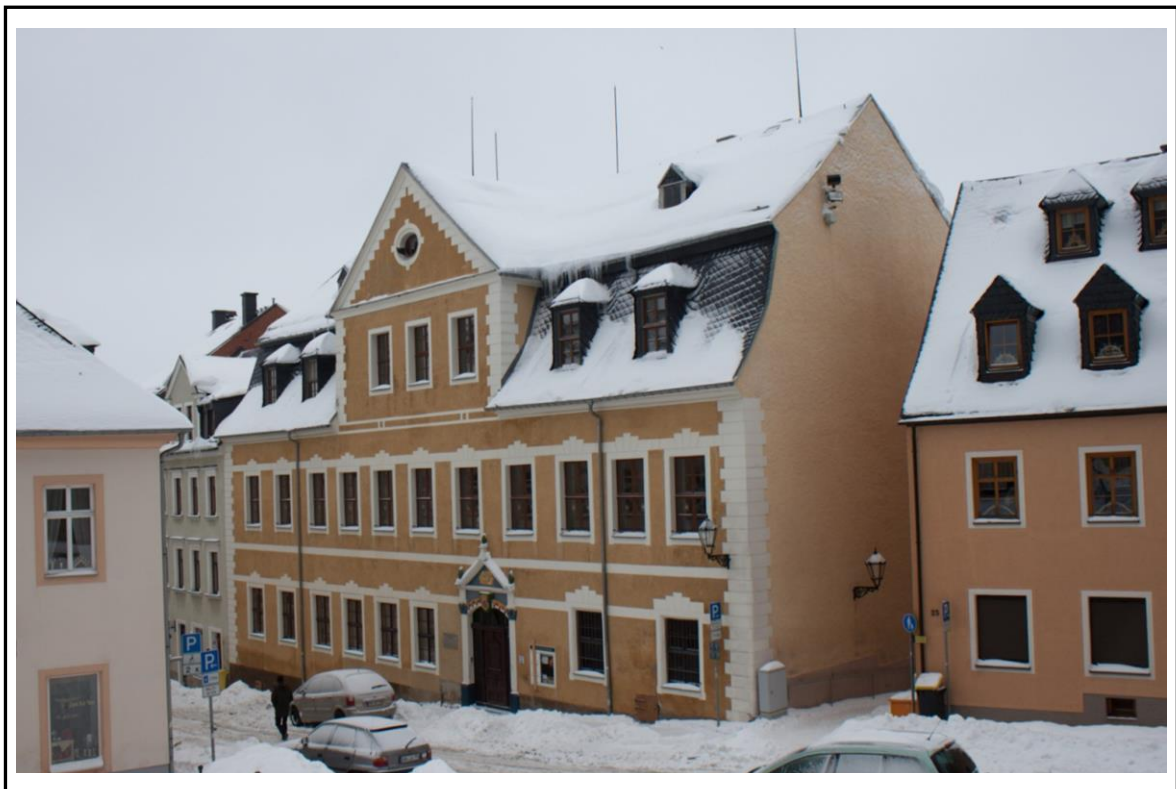
Das ehemalige Wohnhaus von Caspar Kürschner in der Kleinen Kirchgasse unweit der St. Annen Kirche Foto: Jens Pfeifer
